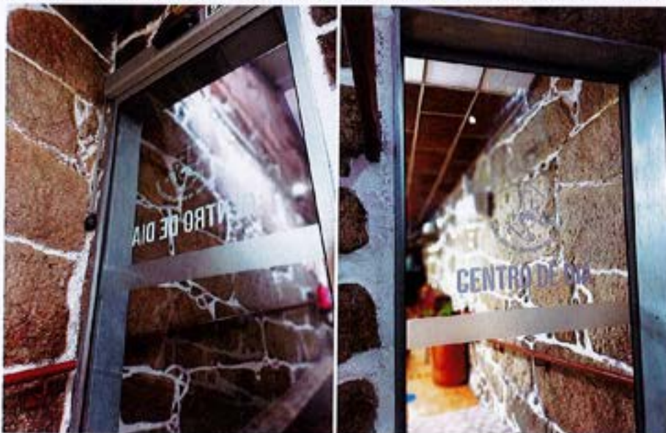
Foto nº 14 – Porta automática na entrada do CD
